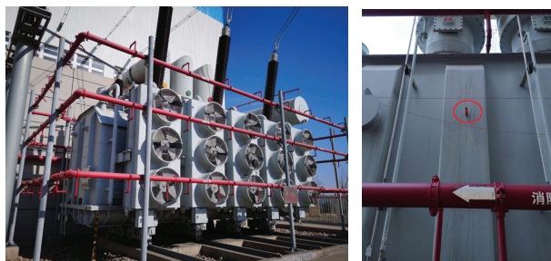
图7 变压器及传感器位置
